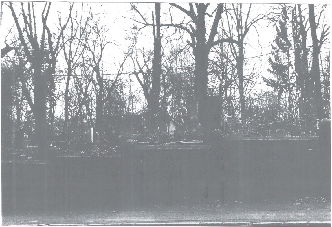
Фото 1. Общий вид ограды типа 1
